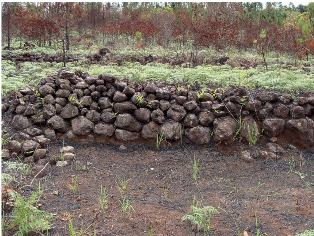
Figure 2: Terrasses empierrées du site KKA 003 à l'île des Pins (cliché Louis Lagarde, 2010)
